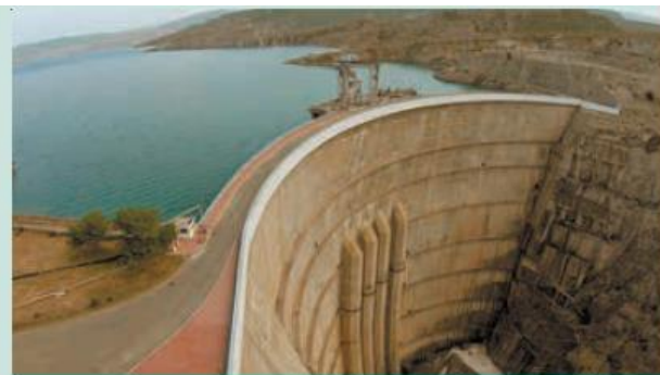
Вид сверху на арочную плотину Чиркейской ГЭС (Республика Дагестан)
